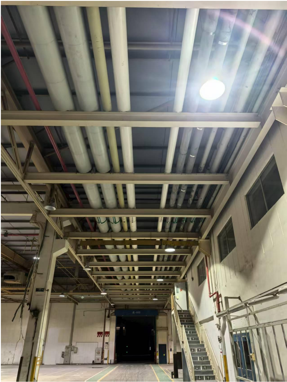
附件3：拆除惠创未来城厂房废旧管道及办公室空调设备工程现场照片
