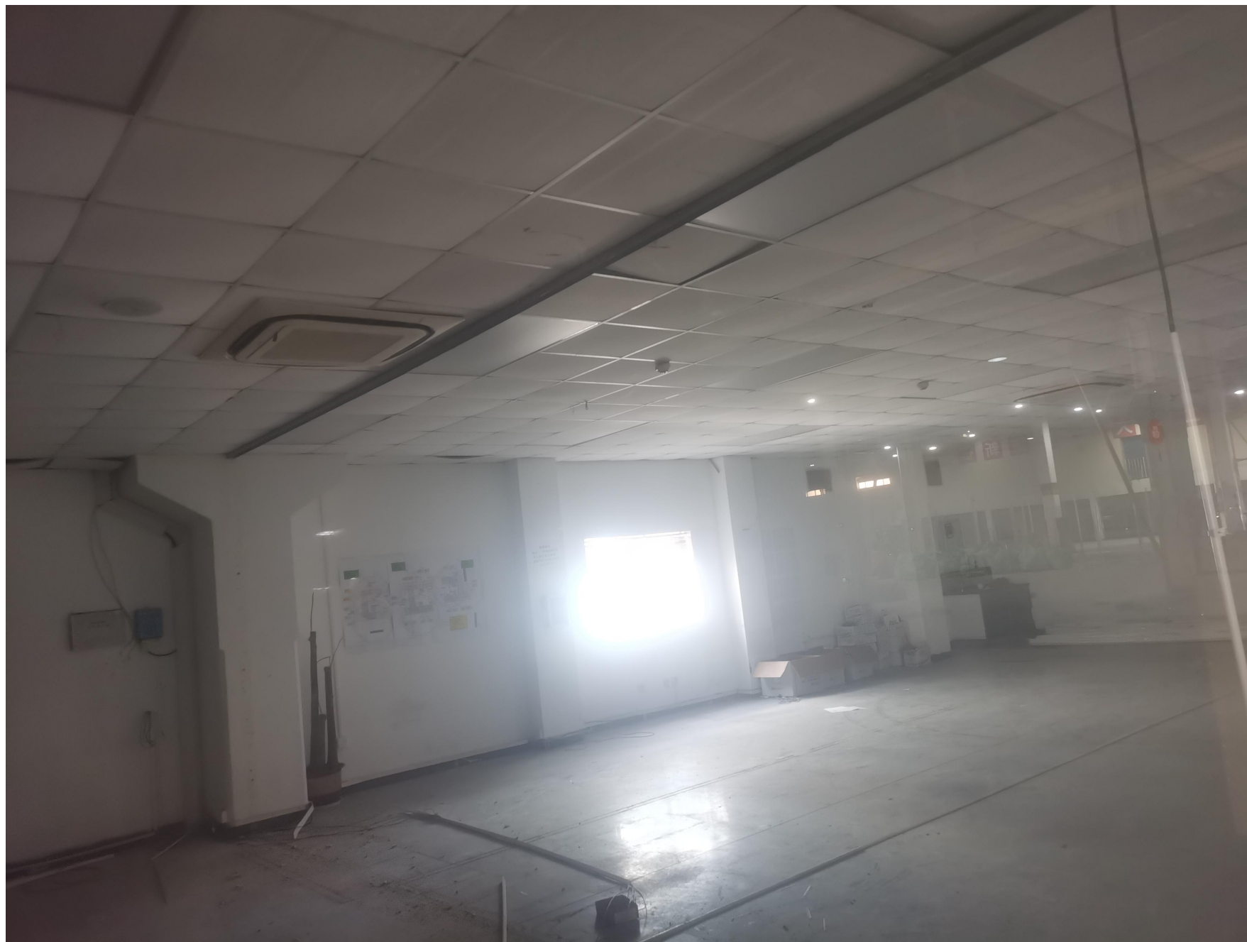
附件3：拆除惠创未来城厂房废旧管道及办公室空调设备工程现场照片
